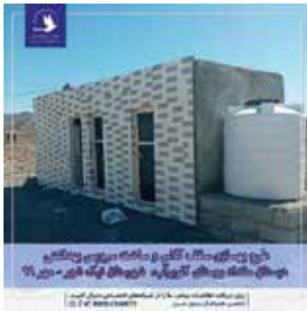
طرح بهسازی سقف کلاس و ساخت سرویس بهداشتی دبستان مقداد روستای کلور آب، شهرستان نیکشهر - مهر ۹۹
