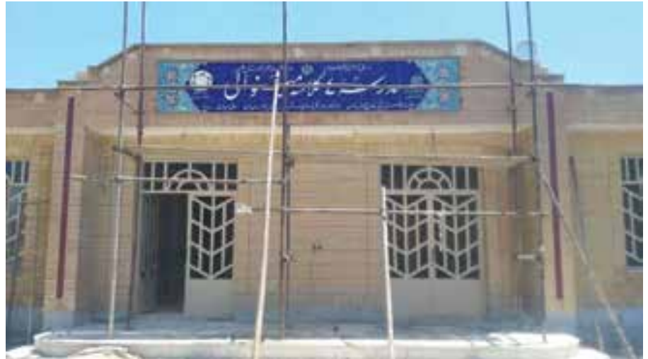
» طرح تکمیل ساخت مدرسه ۴ کلاسه (بعد از اجرا)
